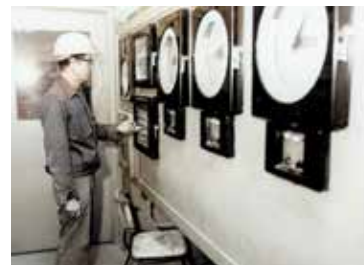
1960s sistemas de control de temperatura del horno de ladrillos
