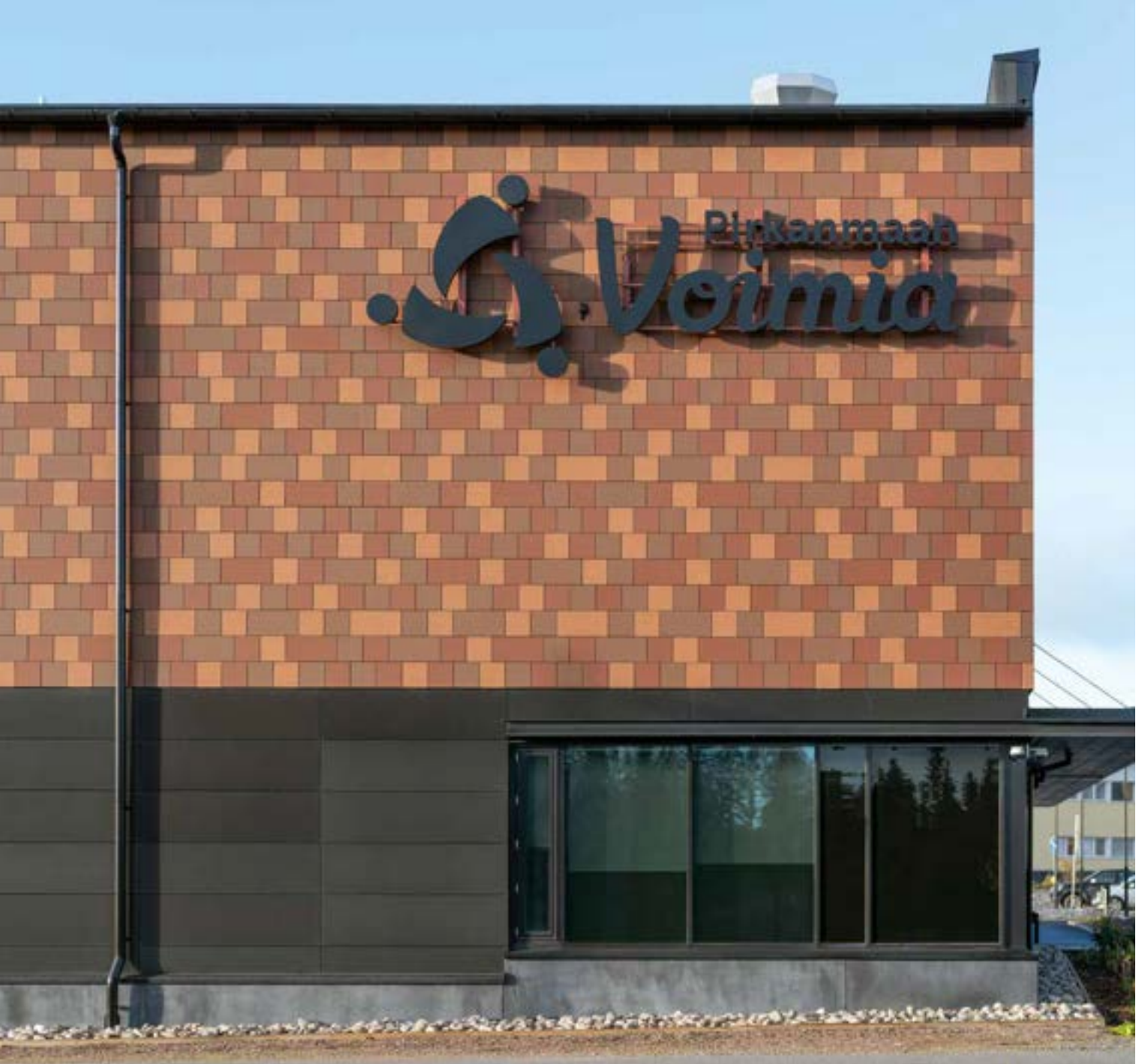
Commercial Kitchen Voimian Pata, Tampere, Finland / Architect: RE-Suunnittelu Oy Products: Design unglazed, KeraTwin®, KeraTwin K20®, Natura unglazed / Photo: Näkymät Visuals OY – ABL-Laatat
