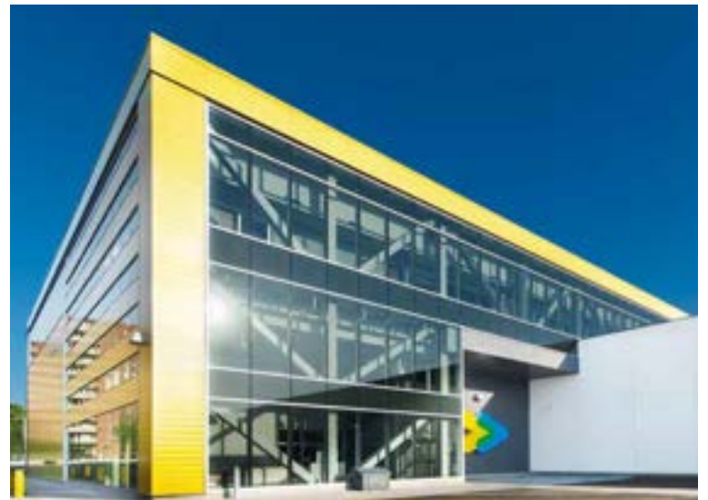
Société de Transport de Montréal, Montreal, Canada / Architect: Lemay / Photo: Marcin Wozniak / LEED GOLD
